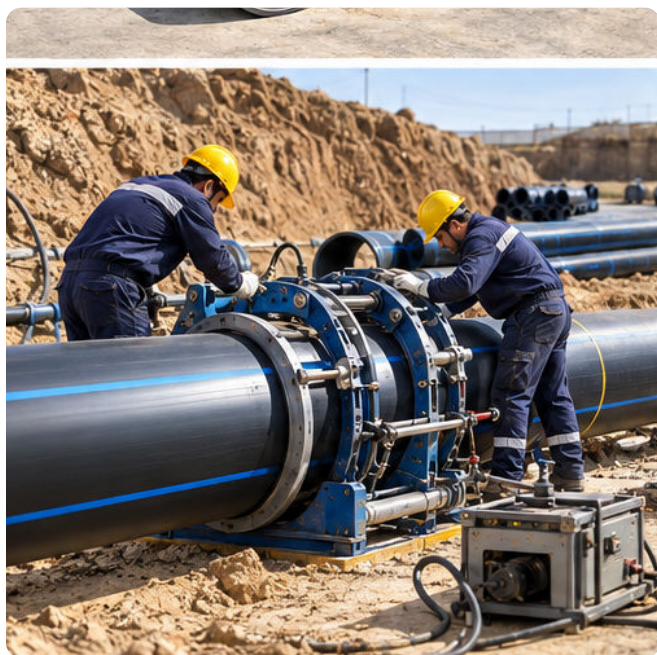
اجرای اتصال جوشی لوله پلی اتیلن در محل پروژه
